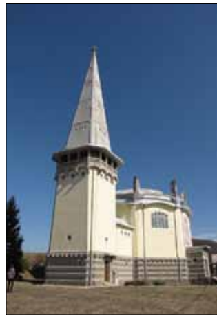
Rárósmulyad vasbeton temploma
