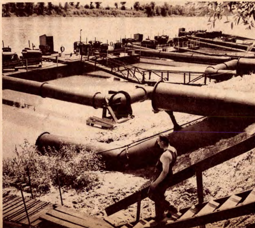
A Tiszasülyi Állami Gazdaság rizstábláira a nagy szivattyúegység percnként 120 liter vizet emel át a Tiszából. (MTI fotó)
