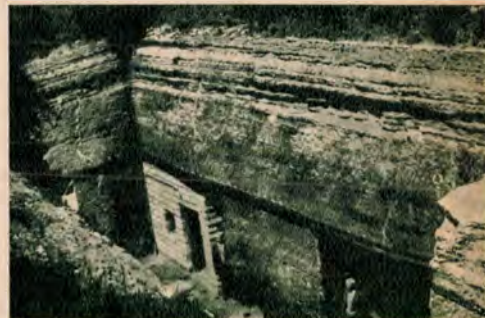
A mennyezetén látszanak a lépcsős fejtés nyomai
