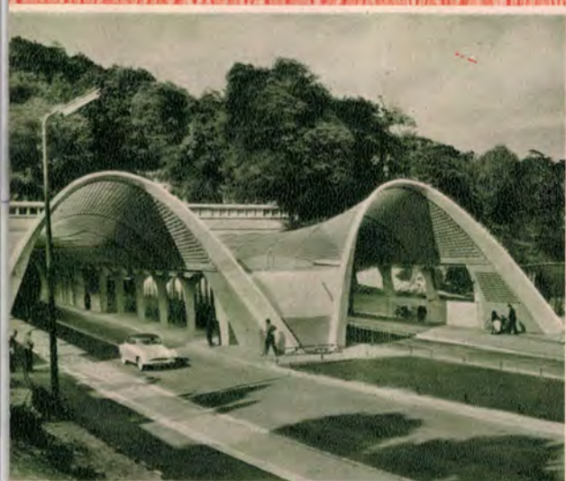
Franciaország. A Le Havre-i alagút bejárata
