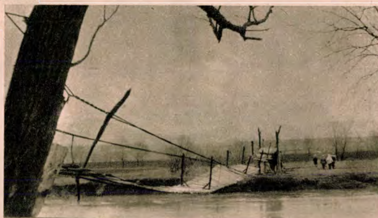
A „lógó híd”
