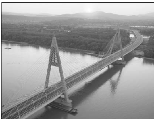
1. ábra Az elkészült híd
