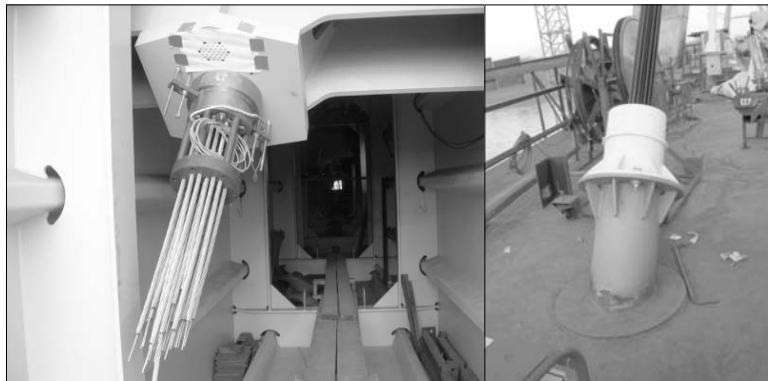
8. ábra Kábelpontok a főtartón
