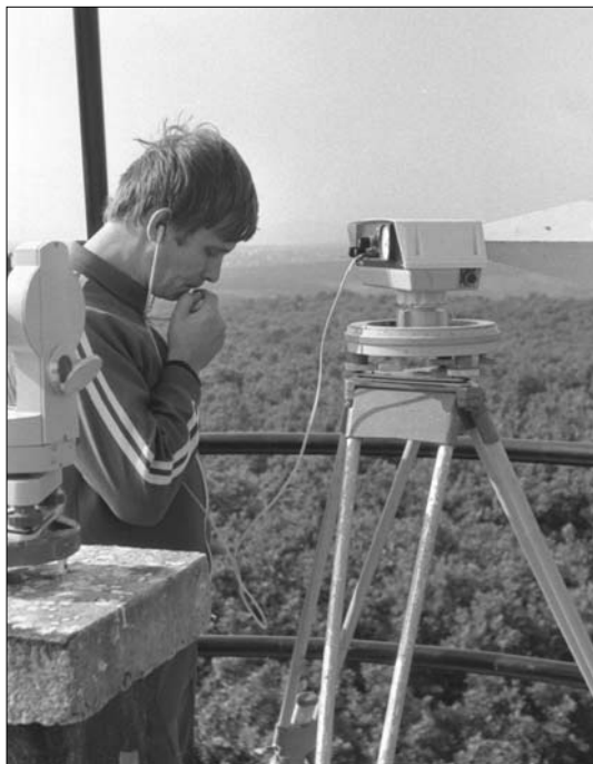
Tellulométeres mérés a Felsőörsi-hegyről
