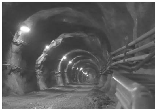
4. kép Alagút 10%-os lejtéssel, közműekkel felruházva
