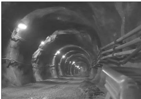
4. kép Alagút 10%-os lejtéssel, közműekkel felruházva
