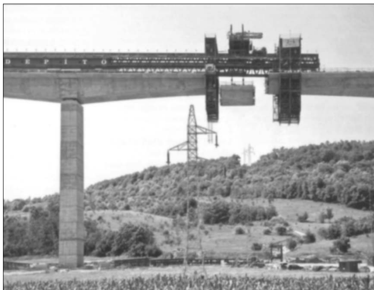
5. ábra A mérlegágakat alkotó hídelemek (zömök) záráskor
