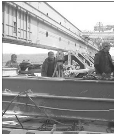
9. ábra Irányzás geodiméterrel Fotó: Matuszka László
