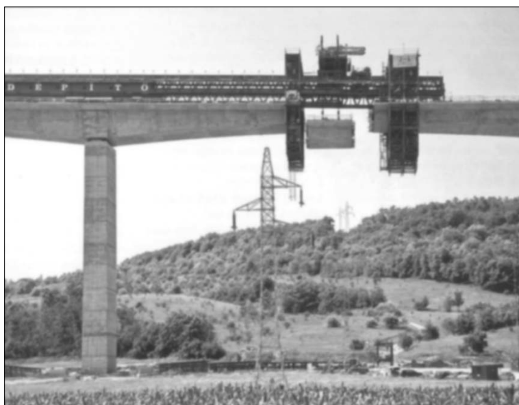
5. ábra A mérlegágakat alkotó hídelemek (zömök) zárásakor
