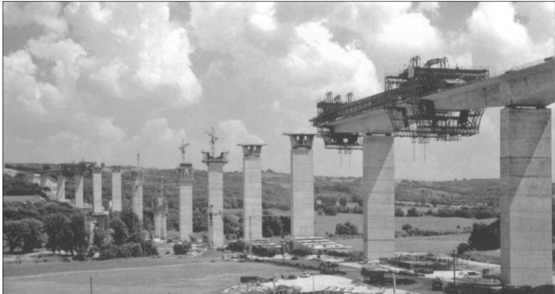
6. ábra A segéd-szerelőhid helyzete munka közben Fotó: Barta János
