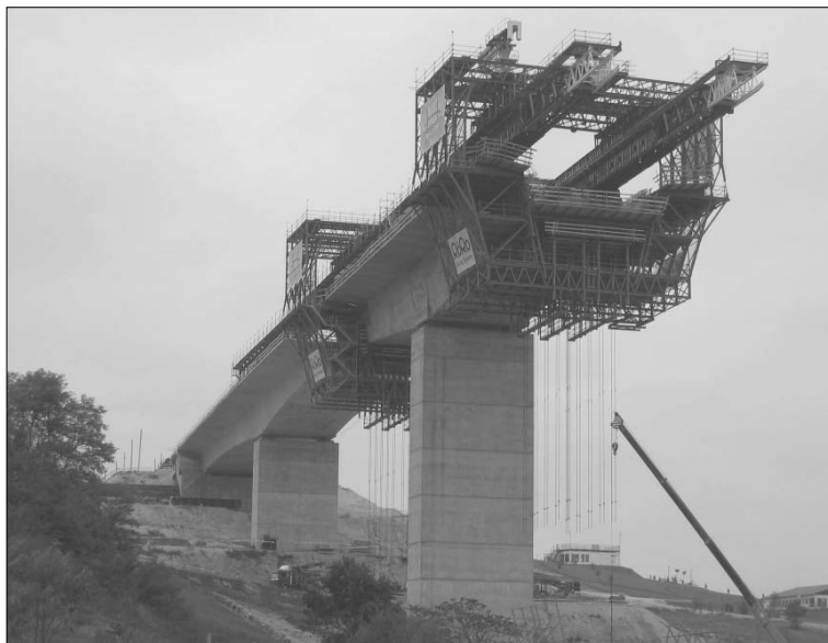
4. ábra A segéd-szerelőhíd
