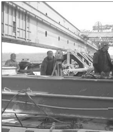
9. ábra Irányzás geodiméterrel Fotó: Matuszka László
