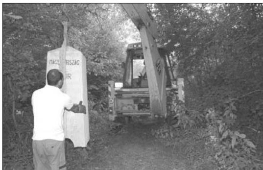
3. ábra Az oszlopok kimozdítása
