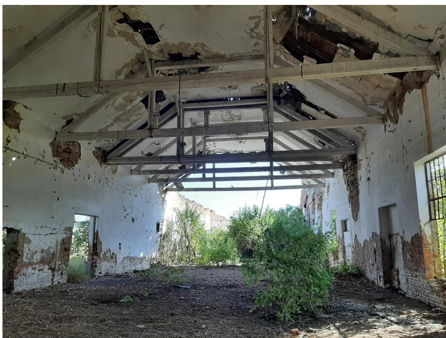
4. ábra Omladozó épület az egykori kendergyárnál (Saját felvétel, 2022. augusztus)
