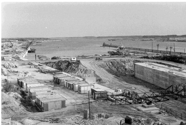
5. ábra: A bősi zsiliprendszer építési munkálatai, 1988
