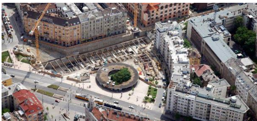
10. ábra: A metróállomása építésének 2007-es állapota a Móricz Zsigmond körtéren
